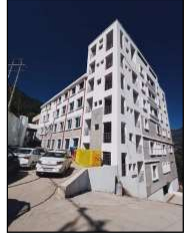
जोनल अस्पताल के नजदीक निर्माणाधीन मद्र चाइल्ड केयर सेंटर।
