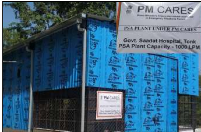
टोंक सआदत अस्पताल में प्रभारी मंत्री ने ऑक्सीजन प्लांट का वर्चुअल उद्घाटन किया
